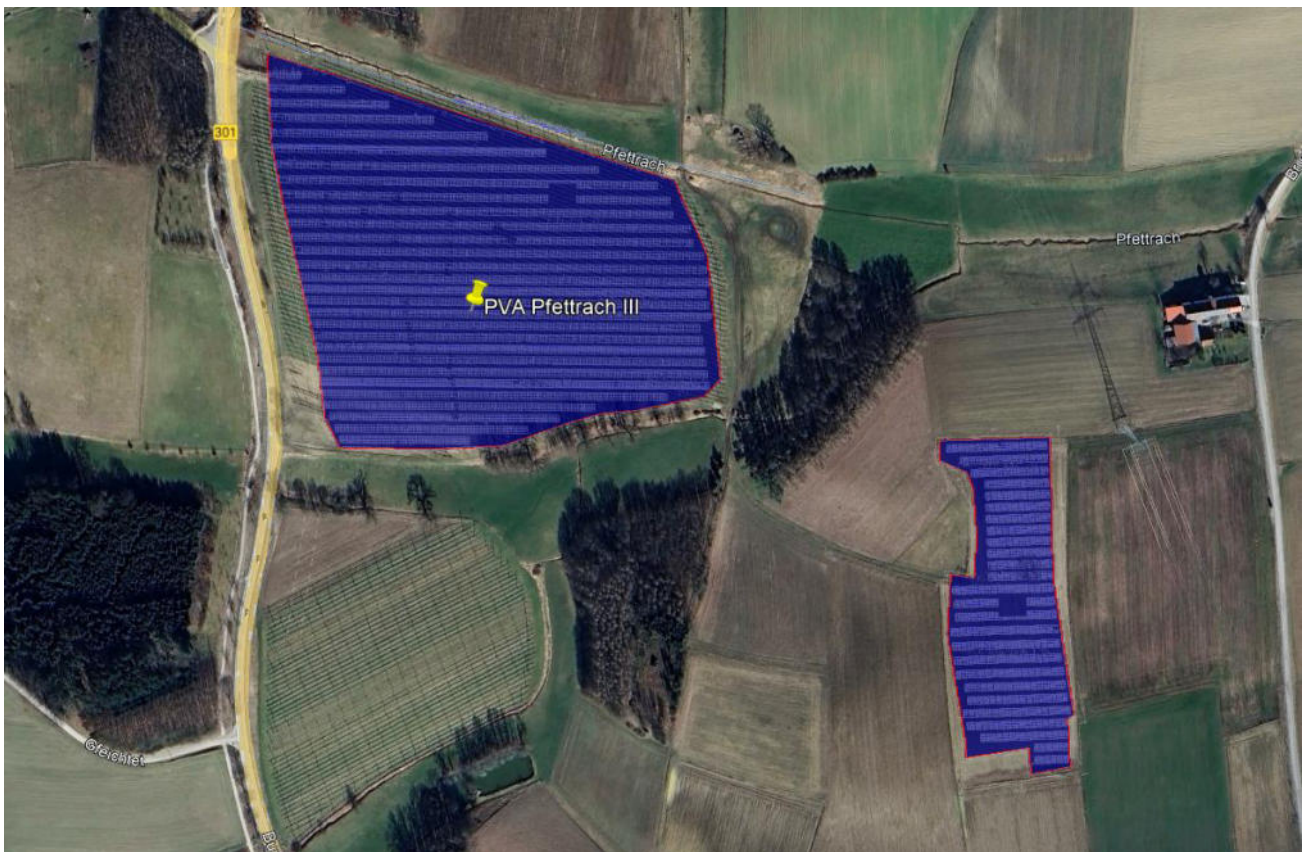
Bild 2.1.3: Details der PV-Anlage (Quelle: Google Earth / SolPEG)
